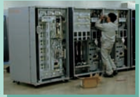
搬入時の連結作業
